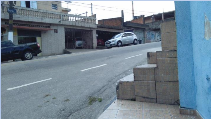
Degraus nas calçadas
